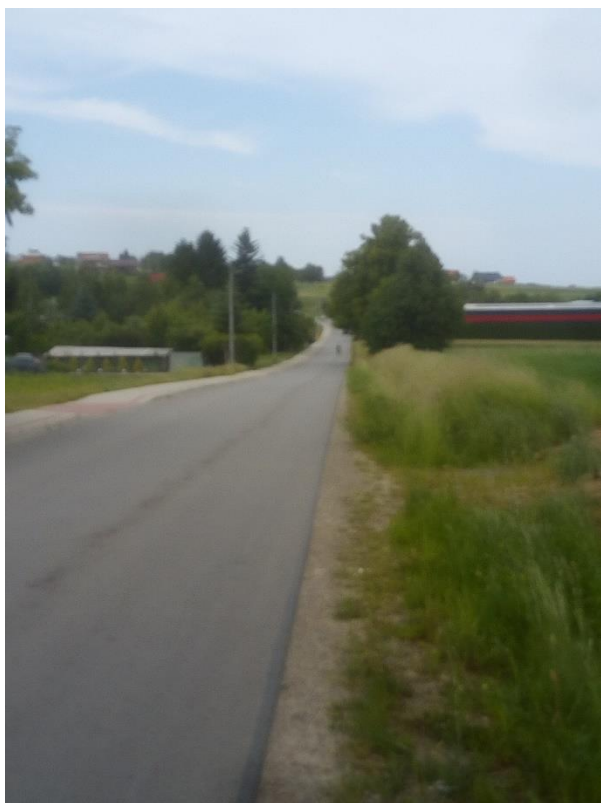
Rysunek 18. Oświetlenie uliczne przy drodze Husów - Lipnik
