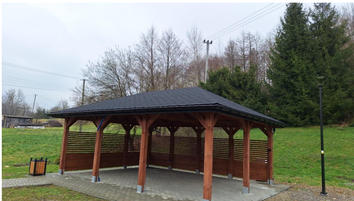
Rysunek 23. „Wykonanie oświetlenia terenu przy Ośrodku Kultury w Tarnawce wraz z robotami towarzyszącymi”.
