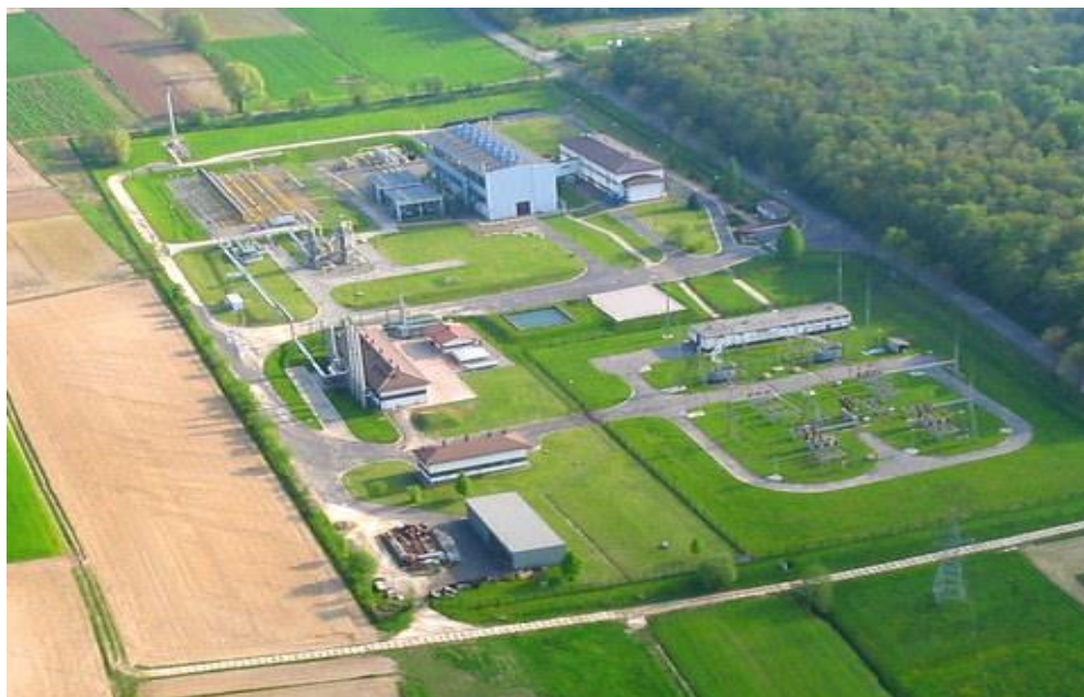
Rysunek 3. Podziemny Magazyn Gazu Husów – widok z góry
