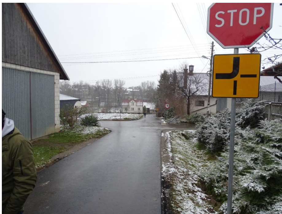
Rysunek 17 . Remont drogi gminnej publicznej Markowej.
