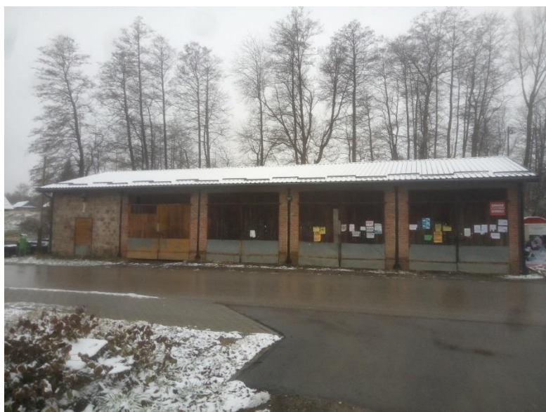
Rysunek 23 . Wykonanie dachu na budynku magazynowym w Tarnawce
